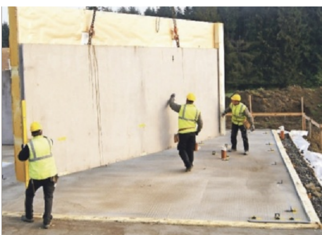
Ein PamaFlex-Element „von innen“ gesehen, mit der dicken Polyurethanisolierrschicht auf der Außenseite.
