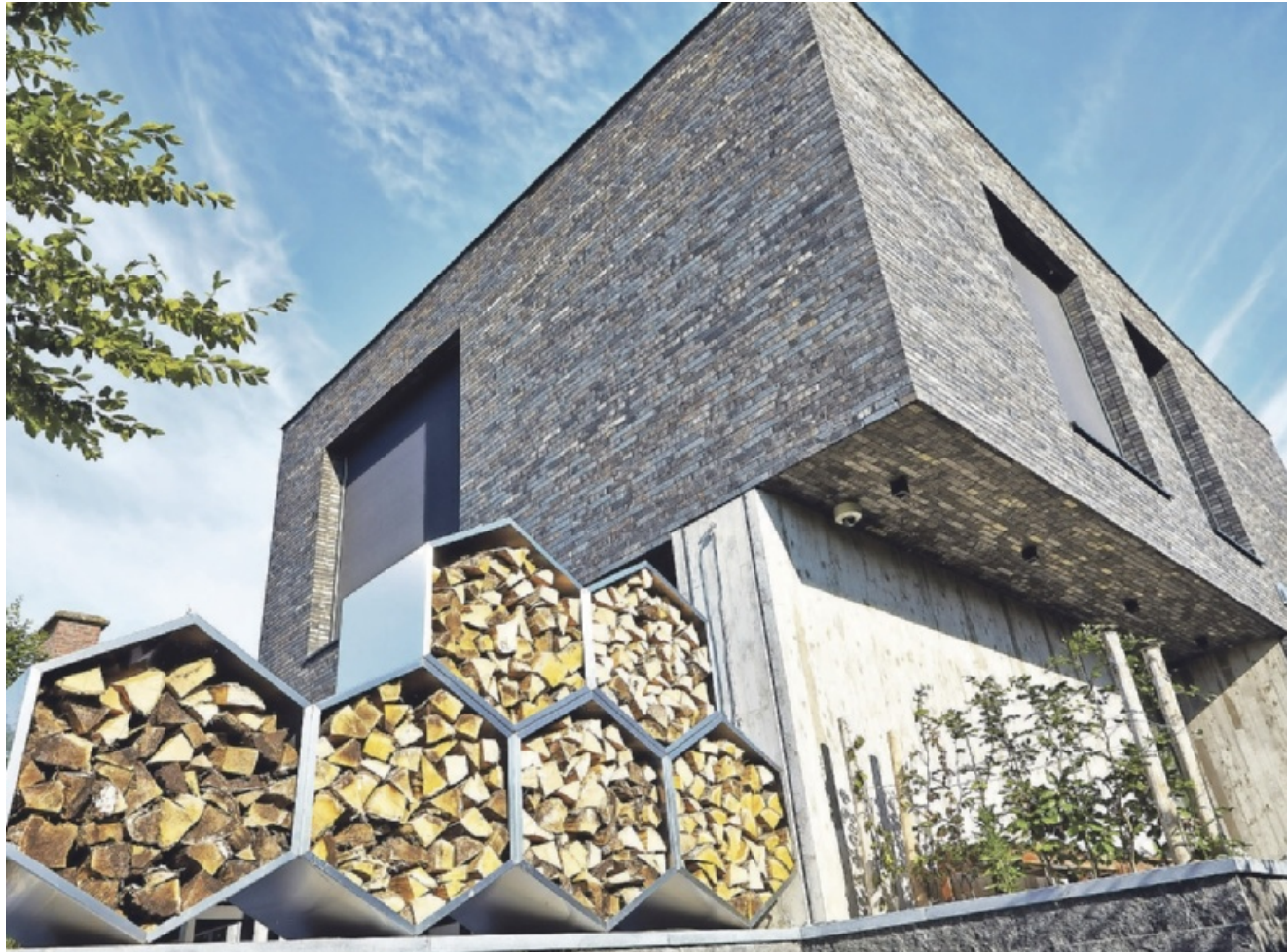
Ein Passivhaus in Lennik, in Vlaams-Brabant, gebaut von H.P. Linden. Die PamaFlex-Elemente im Obergeschoss sind dekorativ mit hochwertigen grau-schwarz schattierenden Ziegeln verkleidet. Fotos: Betrieb
